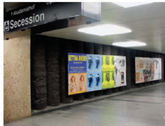
Bohrpfahlwand
